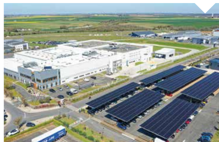
Ombrière photovoltaïque sur le projet Chiesi
