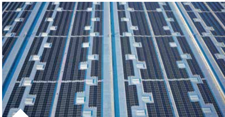
Installation d'une centrale photovoltaïque
