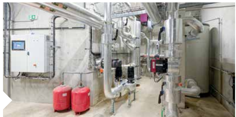
Installation d'une station géothermique à l'échelle d'un parc
