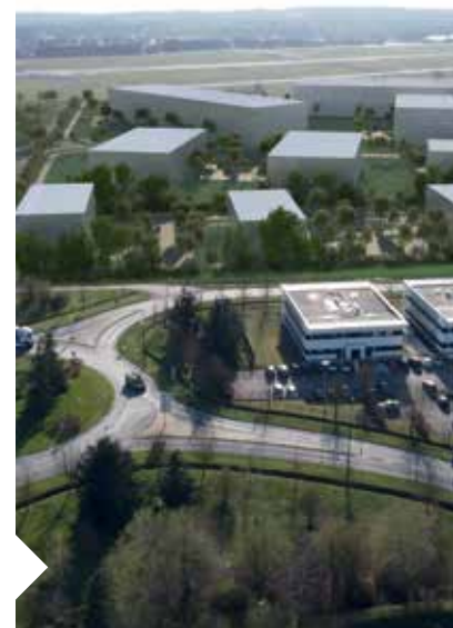
43 ha réhabilités à partir d'une friche militaire à Creil (60)
